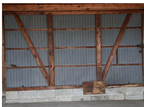
一般宅片付け 作業後 ②
