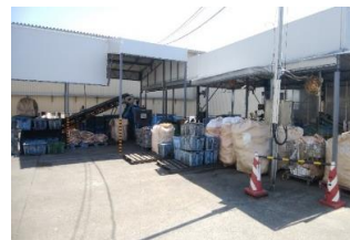
アルミ圧縮機移設後
