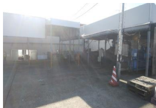
アルミ圧縮機移設前
