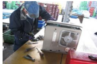
電気製品等の解体作業;1名
